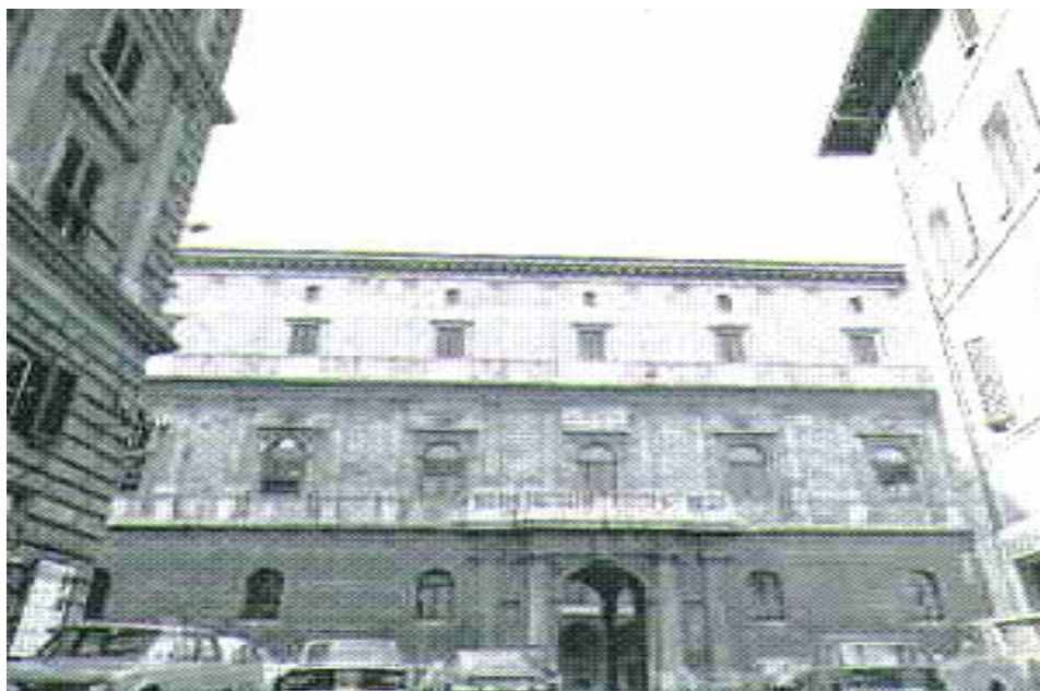
Roma: Palazzo della Cancelleria in Corso Vittorio Emanuele II
