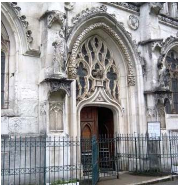
Reale Abbazia di Altacomba - particolare (foto Tricolore)
