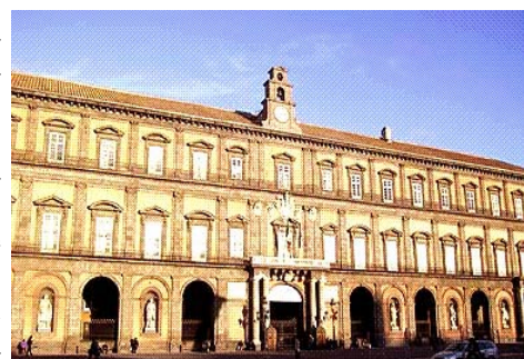
Ingresso del Palazzo Reale di Napoli
